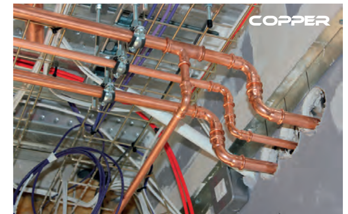
Installationsbeispiele von PCC Pressverbindern / Installation examples for PCC press fittings
